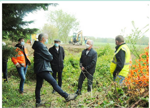
La voie verte, reliant le Canal du Midi, à hauteur de Bram, et le château de Montségur prend forme à Montréal.
